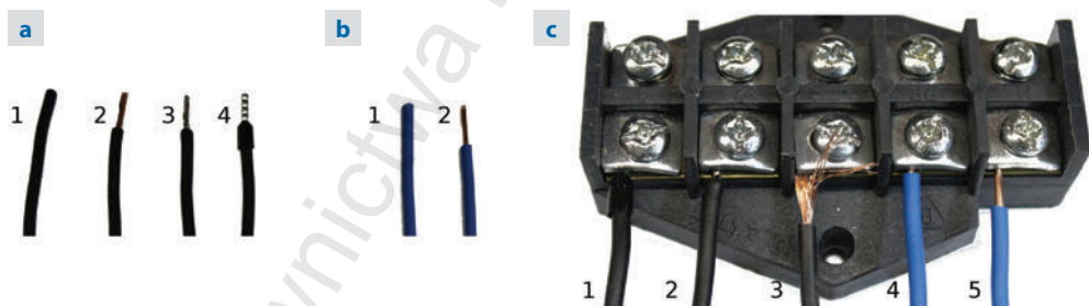
Rys. 1.12 Kolejne etapy wykonywania połączenia skręcanego na listwie zaciskowej a – dla linki (1 – ucięty przewód, 2 – odizolowana końcówka, 3 – końcówka oblutowana, 4 – koniec okuty końcówką tulejkową), b – dla drutu (1 – ucięty przewód, 2 – odizolowana końcówka), c – przewody zamontowane w zaciskach (1, 2 – prawidłowo zamontowane linki, 3 – źle zamontowana linka – wolne druciki mogą powodować zwarcia, 4 – prawidłowo zamontowany drut, 5 – źle zamontowany drut – zbyt duży odizolowany fragment poza zaciskiem również może być przyczyną zwarcia)
