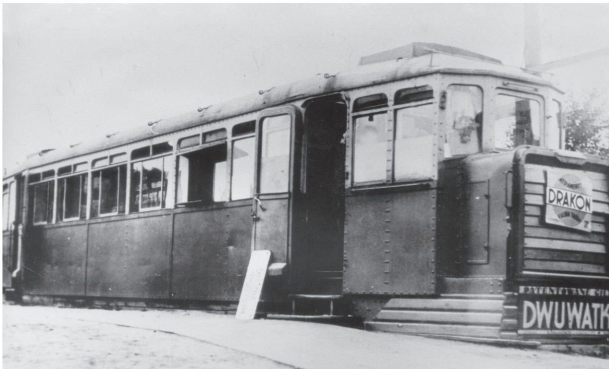
Pudło wagonu motorowego wycofanego z kolei wilanowskiej, ustawione w roku 1935 na stacji końcowej Belweder. Pudło to służyło za poczekalnię i kasę biletową
