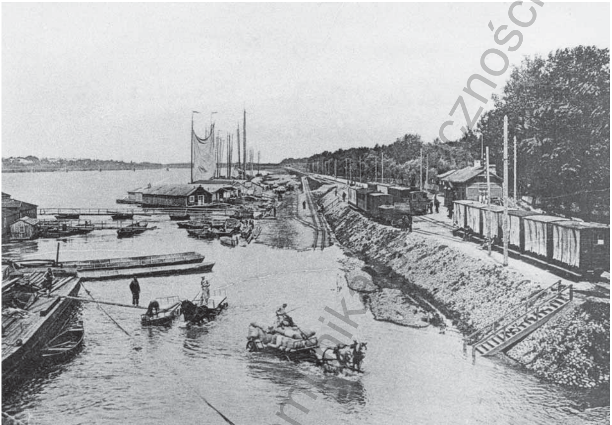
Podczas wylewów Wisły, woda zalewała tory na stacji Most. Widoczne prowizoryczne tory ułożone na wale przeciwpowodziowym (w kierunku Jabłonnny) – prawdopodobnie w 1904 roku
