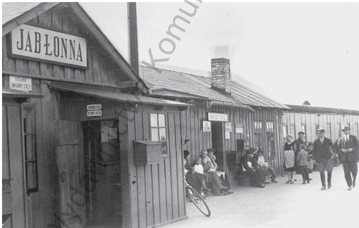
Budynek stacji Jabłonna II. Po lewej stronie widoczne wejście do pomieszczenia dyżurnego ruchu i zawiadowcy stacji. Zdjęcie wykonane w roku 1935
