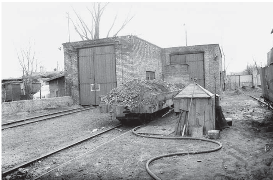
Dwukanałowa hala postojowa parowozów wzniesiona w 1934 roku. Wygląd w roku 1984
