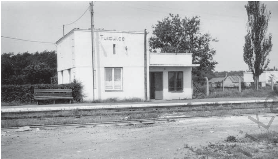
Budynek stacji Tułowice – stan w 1971 roku
