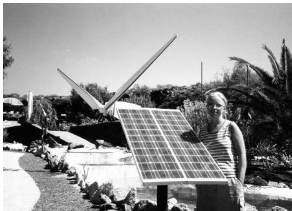
Rys. 4.6. Panel fotowoltaiczny z ogniw polikrystalicznych w parku ITER na Teneryfie [Fot. G. Jastrzębska]
